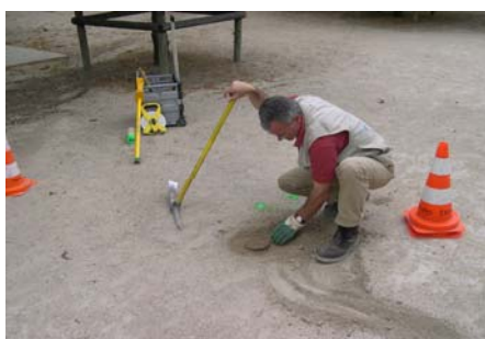
Dégagement des bouches à clés
