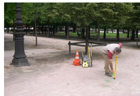
Marquage de la bouche à clé détectée
