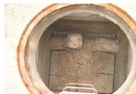
Intérieur du regard pour diagnostic et relevé des points critiques
