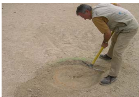
Dégagement pour accès au regard
