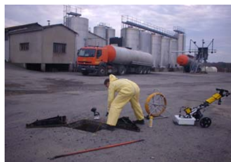
Passage d'une sonde de détecteur pour localiser les canalisations rendues accessibles par l'ouverture du regard
