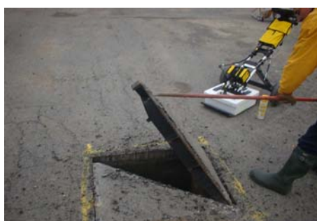
Dégagement de l'enrobé et ouverture du regard
