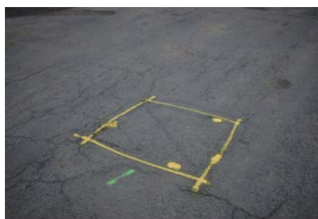
Pointage de l'emprise du regard dans les deux directions par marquage au sol
