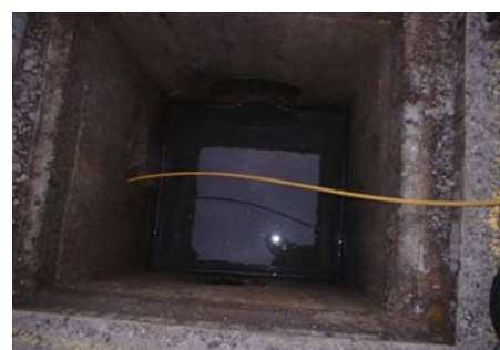
Passage d'une sonde de détecteur pour localiser les canalisations rendues accessibles par l'ouverture du regard
