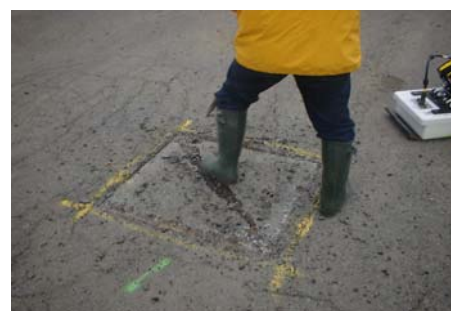
Pointage de l'emprise du regard dans les deux directions par marquage au sol
