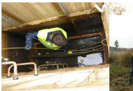
Utilisation d'une sonde à fréquences radio poussée dans le fourreau emprunté par la fibre optique
