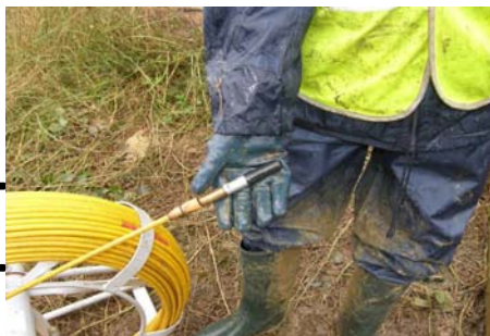
Mise en place du générateur de fréquences sur le réseau RAU
