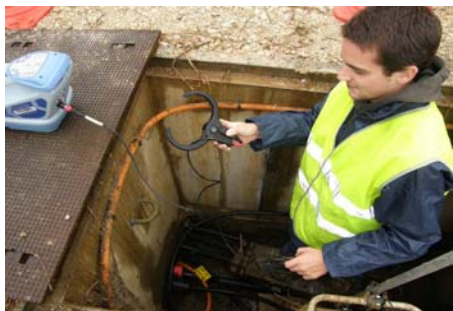
Mise en place du générateur de fréquences sur le réseau RAU
