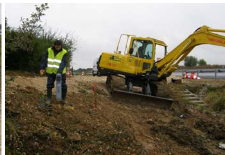
Recherche et positionnement du réseau RAU après calibrage de la fréquence optimale
