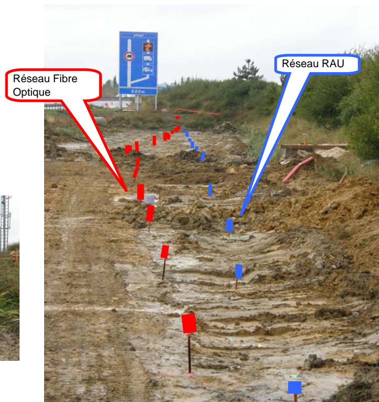
Recherche et positionnement du réseau RAU après calibrage de la fréquence optimale
