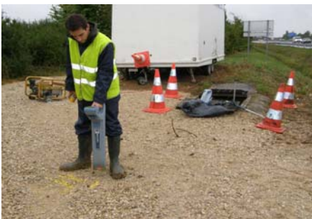
Recherche et positionnement du réseau RAU après calibrage de la fréquence optimale
